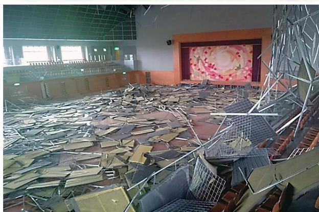
▲本震後の旧総合体育館メインアリーナ 落下した天井材等でフローア面が埋め尽くされた
