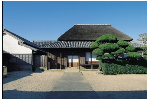
藍屋敷の田中家住宅
