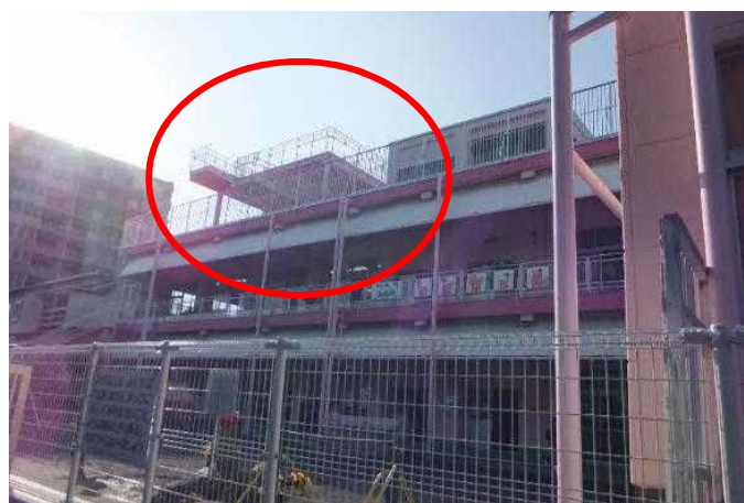
図 15 屋上への避難場所を増築した事例
