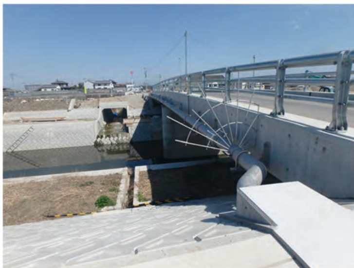
(八坂橋水管橋φ200 令和2年3月竣工)
