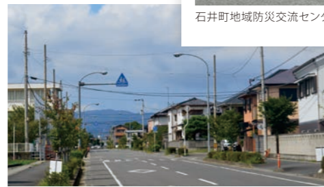
自転車・歩行道など、利便性と安全面に配慮した道路の整備拡充が進む
