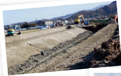
河川改修工事
