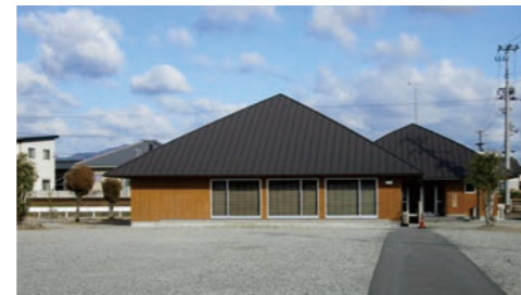
石井町地域防災交流センター
