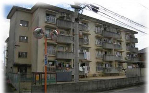
城ノ内住宅団地
