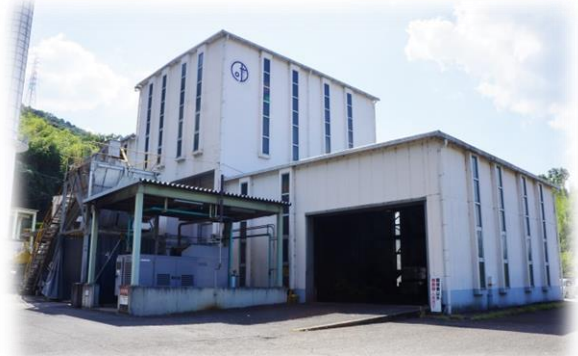
清掃センター (供給処理施設より)
