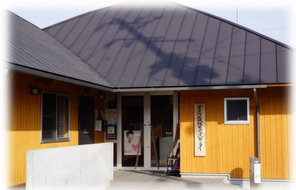
石井町地域防災交流センター
