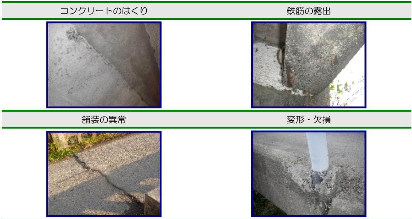
図 3 橋梁の主な損傷例
