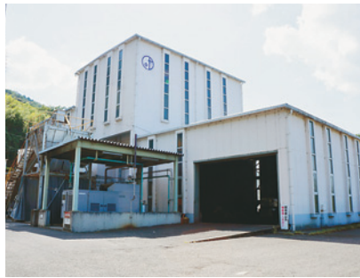
清掃センター 稼働後38年
