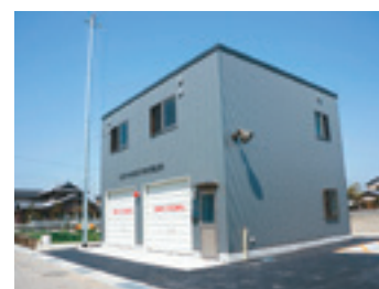
消防団詰所兼一時避難所
