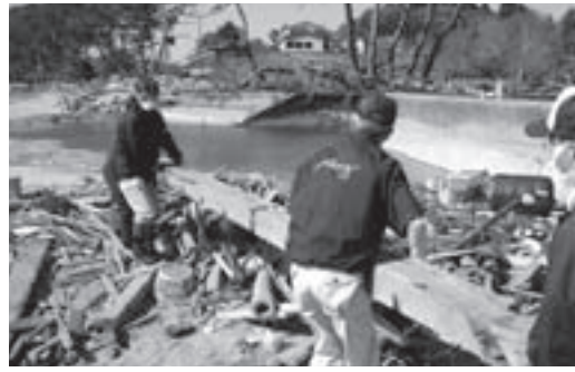
▲ がれきの撤去作業
